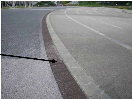
赤線部分の側溝
