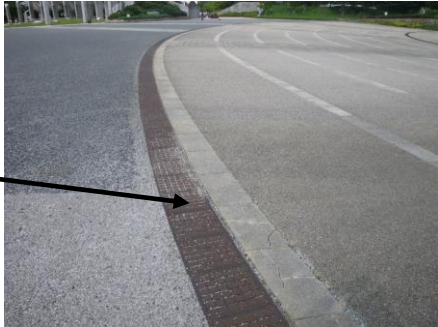
赤線部分の側溝
